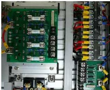
DC 접속반은 용량별로 여러 개의 단위로 구성된 태양전지 모듈을 접속하여 단일String으로 구성하여 태양전지 모듈로부터 생산된 직류전압을 인버터에 공급하는 장치이다. 접속반은 태양광 발전과 풍력발전의 주요 구성품인 발전용 인버터 사이에 사용되며 발전된 전력과 인버터 사이의 정격 보호모듈로 퓨즈 및 다이오드를 이용하여 인버터를 보호하고 각 발전간의 충돌 방지 및 보호기능을 한다.
